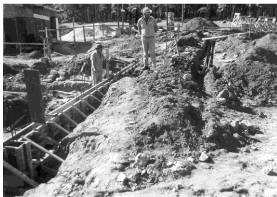
Figura 3: Início da construção
